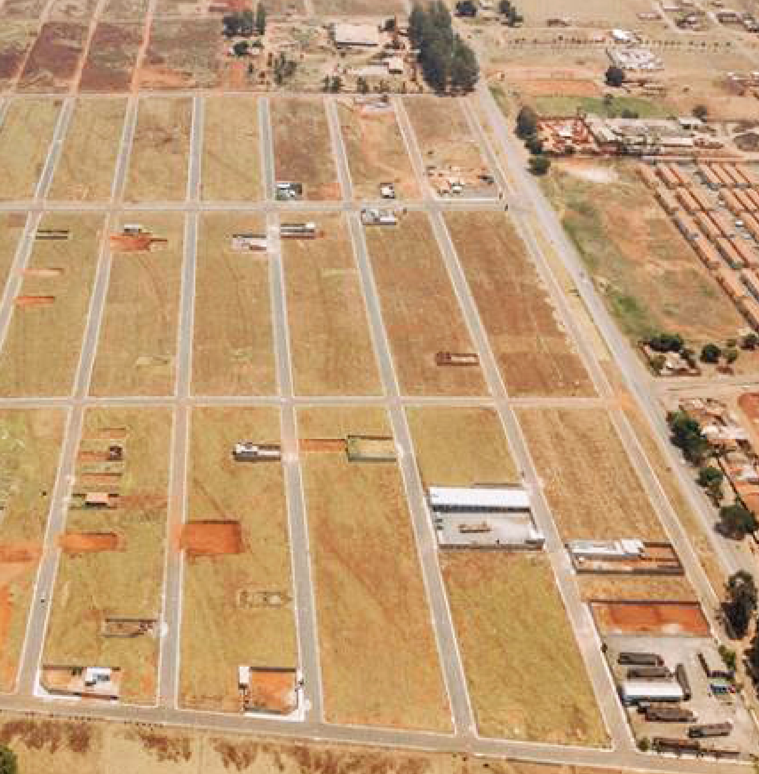
JVF Empreendimentos - Lot. Setor Solange - Trindade / GO
