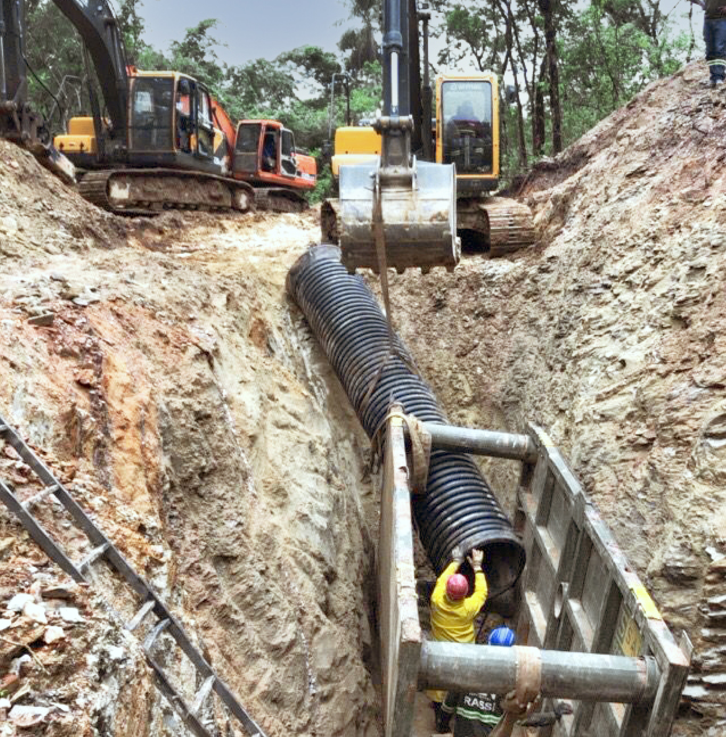
Iguá Saneamento - Interceptor de Esgoto - Cuiabá / MT
